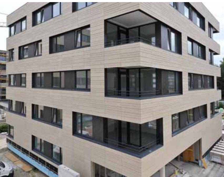
Ein wesentliches Projekt für den Linzer Wohnbau ist die Anlage auf den ehemaligen Gründen der Landesfrauenklinik.
