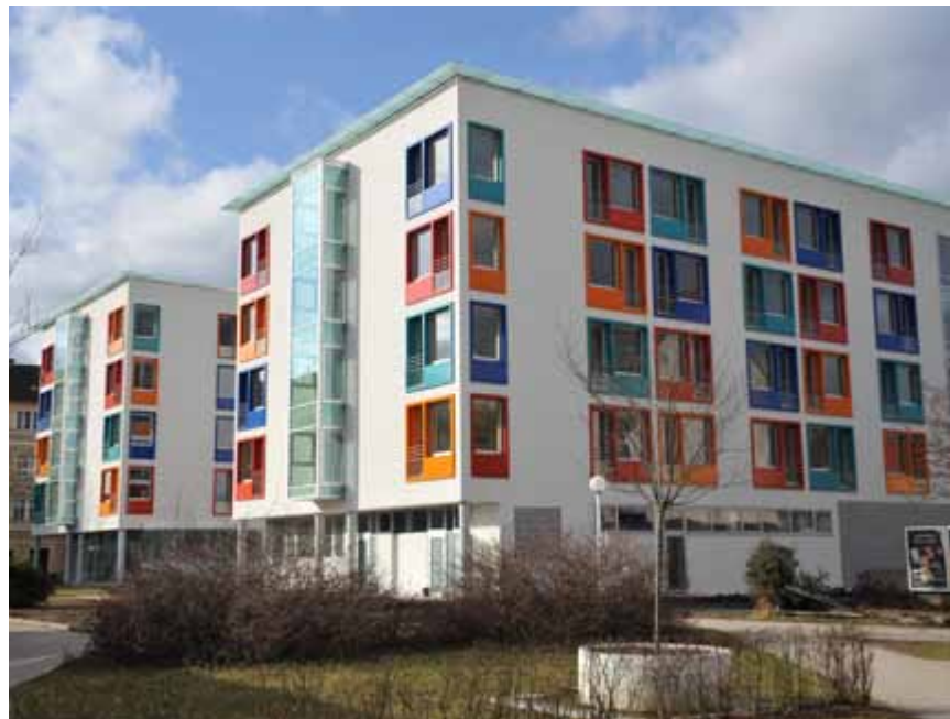
Das Seniorenzentrum Franz Hillinger wurde gänzlich neu errichtet. (Fotos: KOMM)
